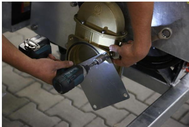
Abb. 18. Stopfen für die Öffnung des Rücklaufs abbauen - Ansicht während des Abbaus mit Maulschlüssel, Steckschlüssel und Schraubendreher
